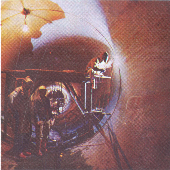
Soldadura de la Tubería de Presión
