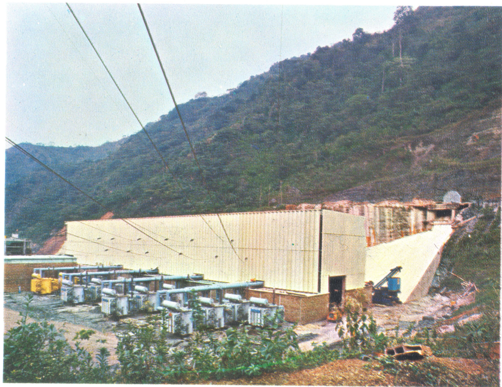
Casa de Maquinas de Chivor I
